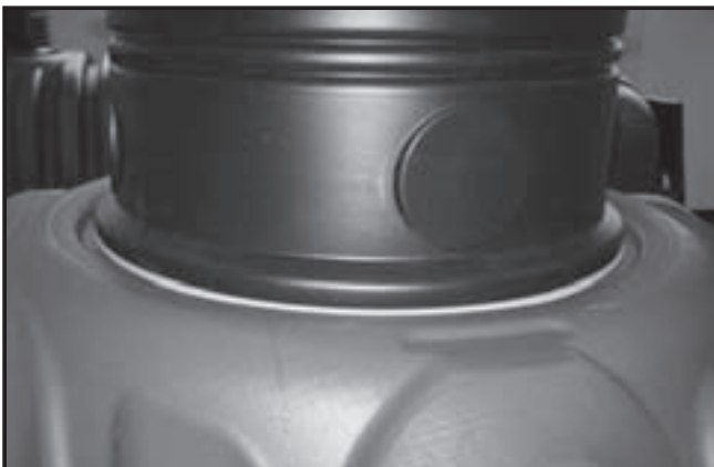
FIG.4 Install Riser
