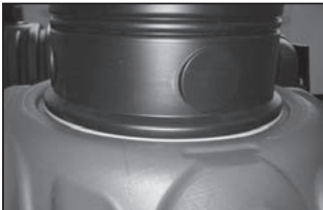
FIG.4 Install Riser
